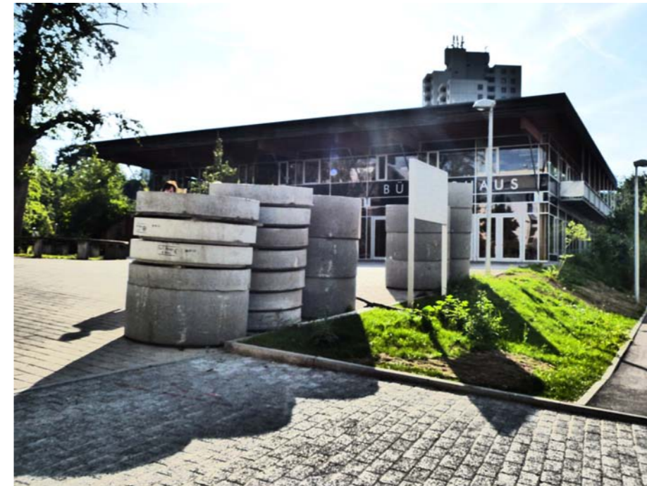
11 Betonschachtringe mit Deckel, gestiftet von der Firma GUSTAV EPPLE, harren vor dem Bürgerhaus ihrer weiteren Verwendung.
